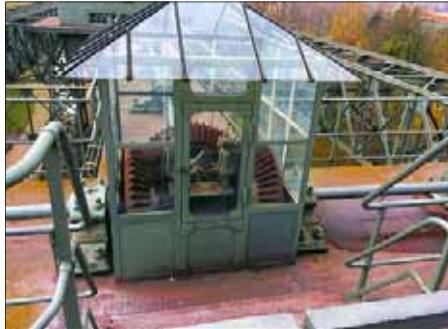
Es wurde nach dem Prinzip eines Mehrkammer-Hebewerkes angelegt. Man muss sich einen großen Trog vorstellen, der auf einer Art Schwimmern montiert wurden. Diese Schwimmer sind so berechnet, dass sie den Trog einschließlich Wasser genau im Gleichgewicht halten. Möchte man ein Schiff auf die obere Scheitelhaltung des Kanals bringen lässt man etwas Wasser aus dem Trog, dieser schwimmt dann auf und hebt den Trog
